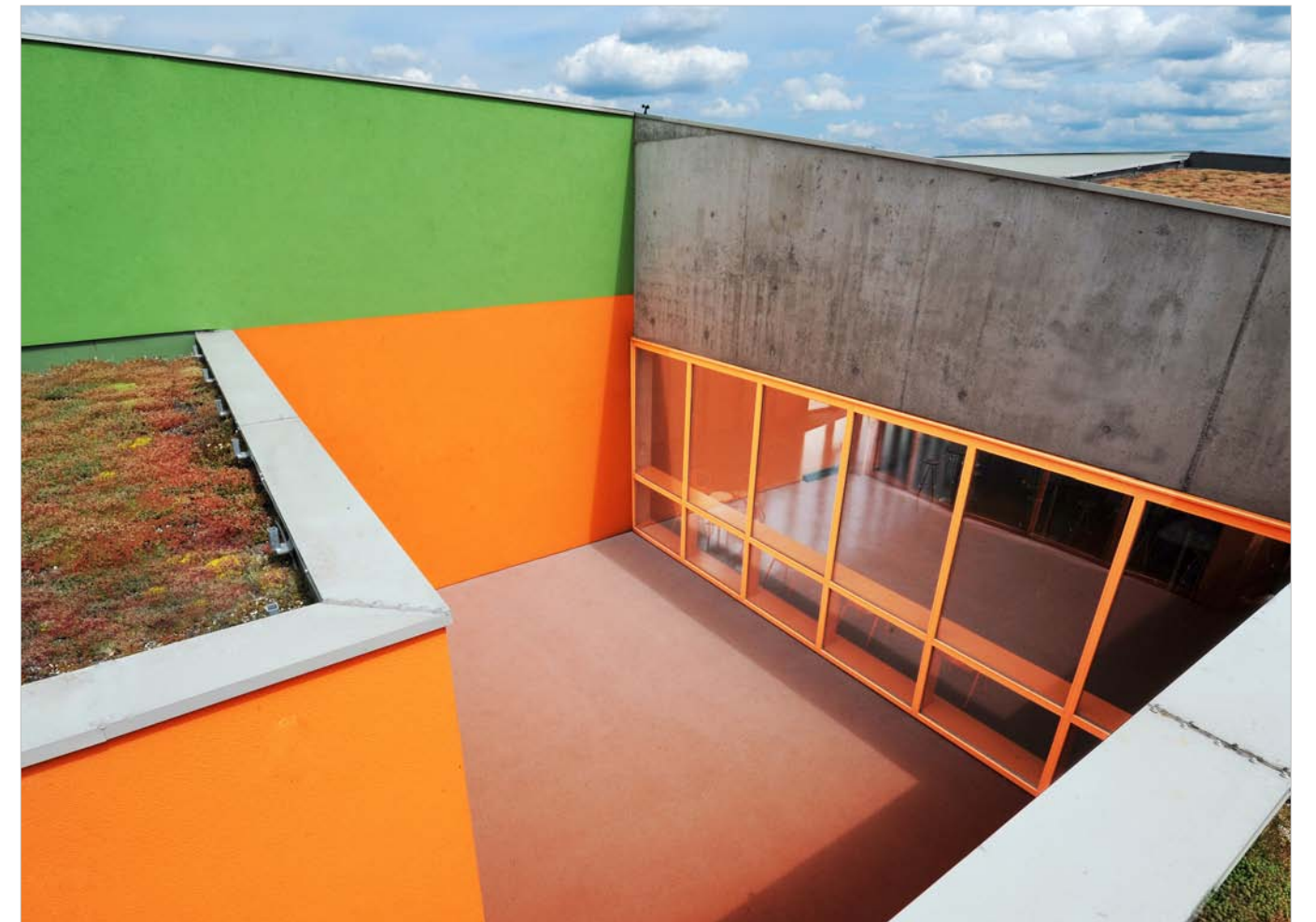
Le Tram, conservatoire de musique et salle festive a été conçu par l'architecte Dominique Coulon, ce projet a gagné le premier prix de l'école d'art de Chicago.
