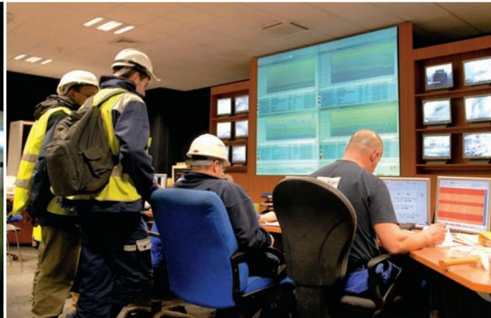
**De la salle de commande (ci-dessus), est contrôlé l'ensemble du processus de valorisation énergétique des déchets. Brassage de la fosse pour assurer un bon rendement calorifique aux deux fours, surveillance de tous les paramètres de sécurité... : une tour de contrôle en activité 7 jours sur 7 et 24 heures sur 24**
