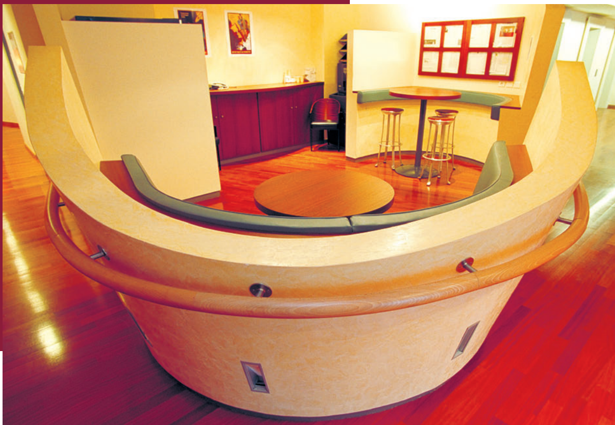
La demi-cloison inclinée et cintrée Placostil® 98/48 de la banquette et les cloisons où filtre la lumière, apportent douceur et bien-être à l'espace détente.
