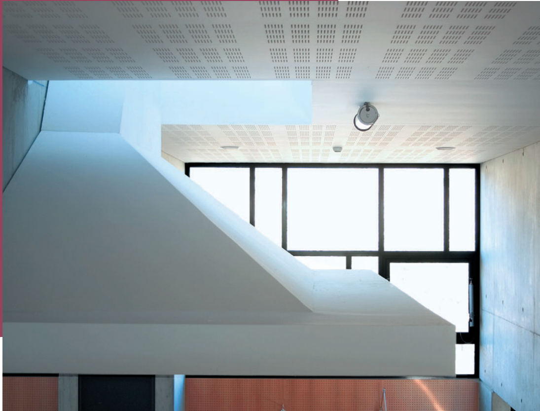
Structure Mégastil® de 12 mètres de long sur 6 mètres de large habillée de plaques Gyptone®, pour cet ouvrage de cinq tonnes entièrement suspendu.
