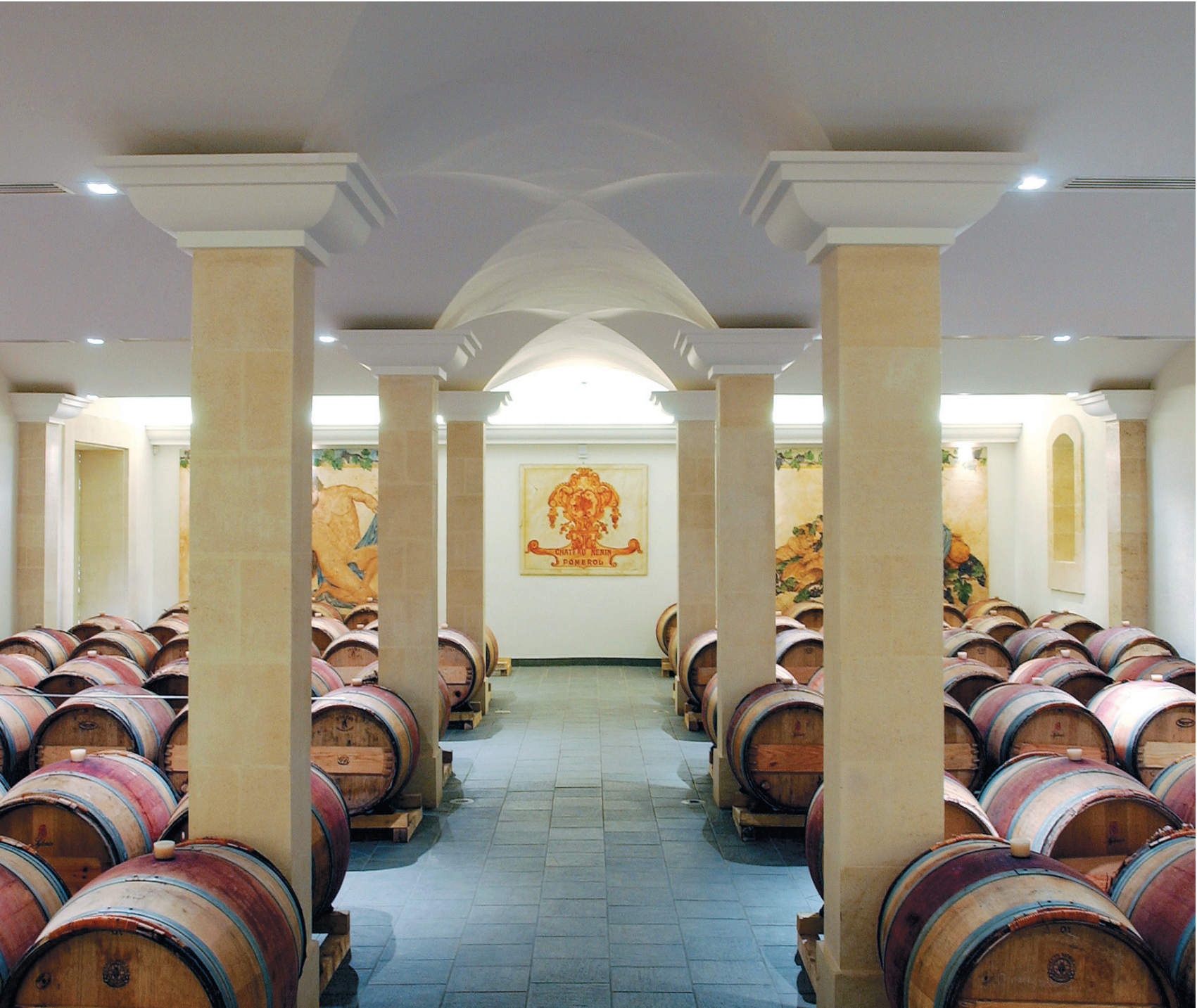
Dans la salle des chais, poteaux et chapiteaux en staff encadrent l'alignement des fûts. À noter : les raccords parfaits entre poteaux, chapiteaux et plafond.
