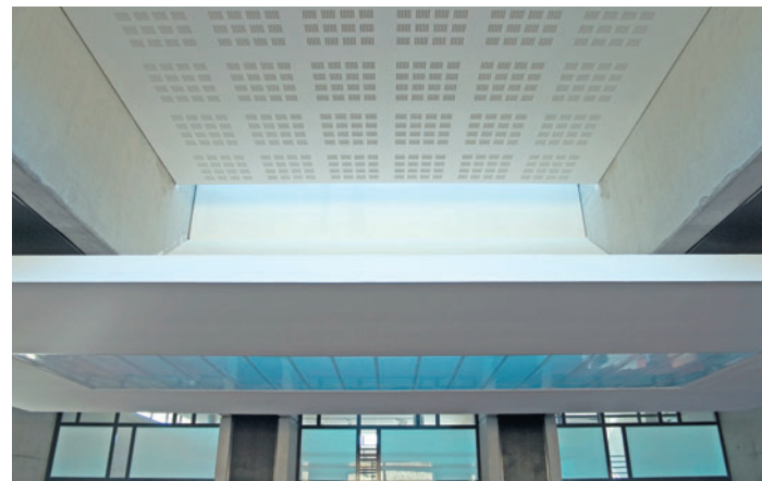
Structure Mégastil® de 12 mètres de long sur 6 mètres de large habillée de plaques Gyptone®, pour cet ouvrage de cinq tonnes entièrement suspendu.
