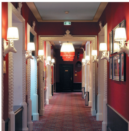
Ci-contre: le couloir avec ses biches et ses chambranles en staff. Page de droite: les moulures du plafond, les chambranles et les corniches en staff du restaurant self-services.
